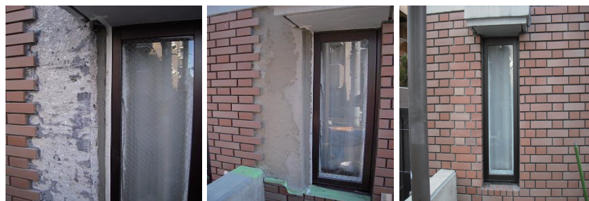
①開口まわりのタイル、シール材を撤去 ②KÖSTER NB エラスティックで防水 ③タイル復旧 施工完了
